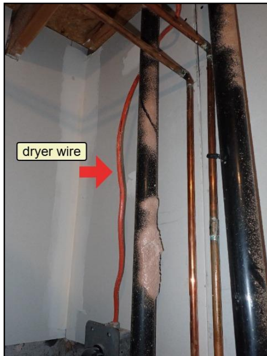
Loose wiring
