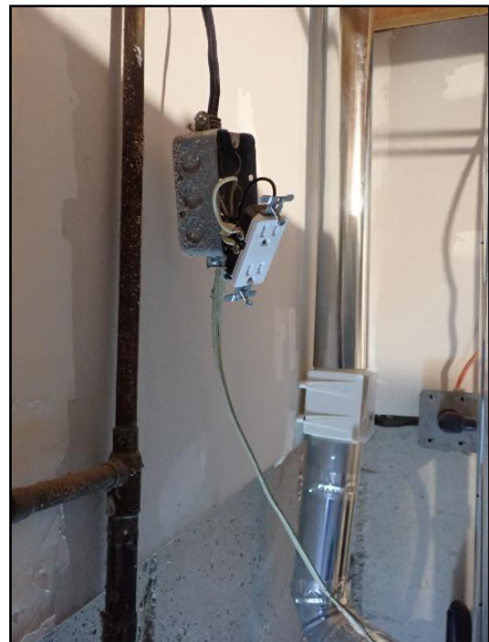
Loose wiring
